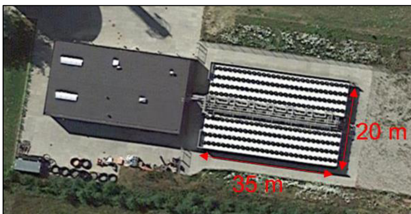
Abbildung 25 Luft-Großwärmepumpe Støvring, Dänemark: 7,9 MW Nennleistung (Komoszynska & Sørensen, 2022) und 700 m 2 Fläche für Luft-Wärmeübertrager (Bildquelle: google.com/maps - © 2023 Airbus)
