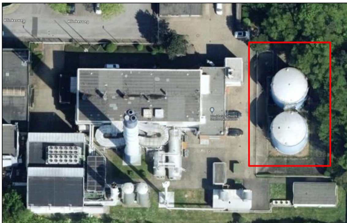
Abbildung 36 Alte Öltanks am FHW (rot markiert)
