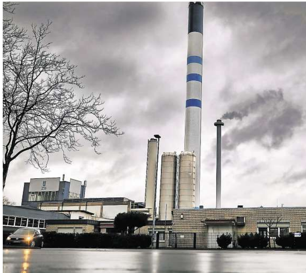
Das Hochdahl-Blockheizkraftwerk wird derzeit noch mit Gas für die Erzeugung von Fernwärme betrieben.
